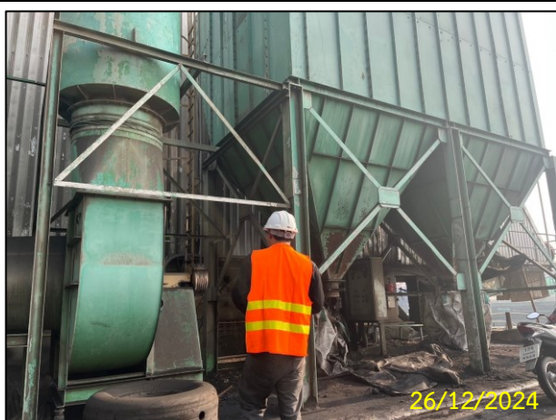
เจ้าหน้าที่ตรวจสอบและบำรุงรักษาระบบกำจัดฝุ่น (Bag Filter)
