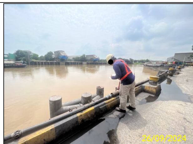
ง) พนักงานคอยตรวจสอบสภาพอุปกรณ์สภาพ หลักผูกเรือ และยางกันชนเรือบริเวณท่าเทียบเรือ
